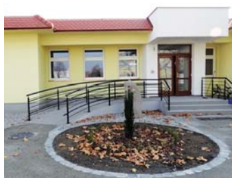
Vstup do výstavného pavilónu po rekonštrukcii.
