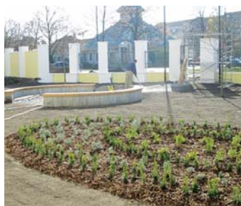
Rekonštrukcia oplatenia pri hlavnom vstupe.
