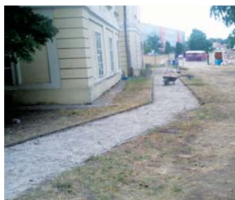
Rekonštrukcia chodníka pri Žitnom kaštieli.
