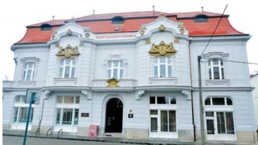
Hlavný vstup do knižnice po rekonštrukcii.
