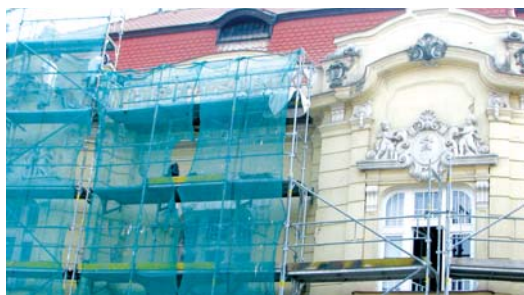
Rekonštrukcia západnej fasády.
